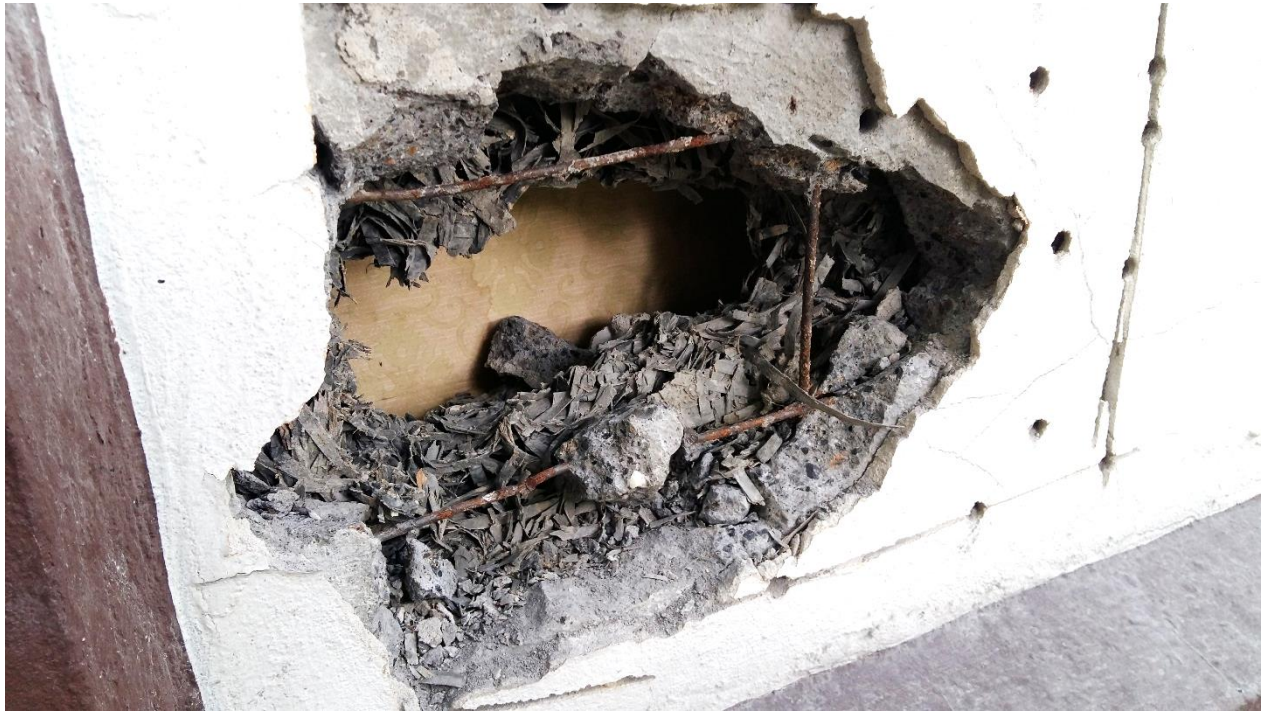
Fot. 1 - odkrywka istniejącej ściany zewnętrznej budynku głównego
