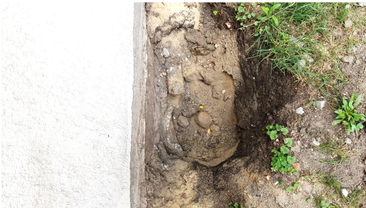
Fot. 3 - odkrywka fundamentu budynku głównego
